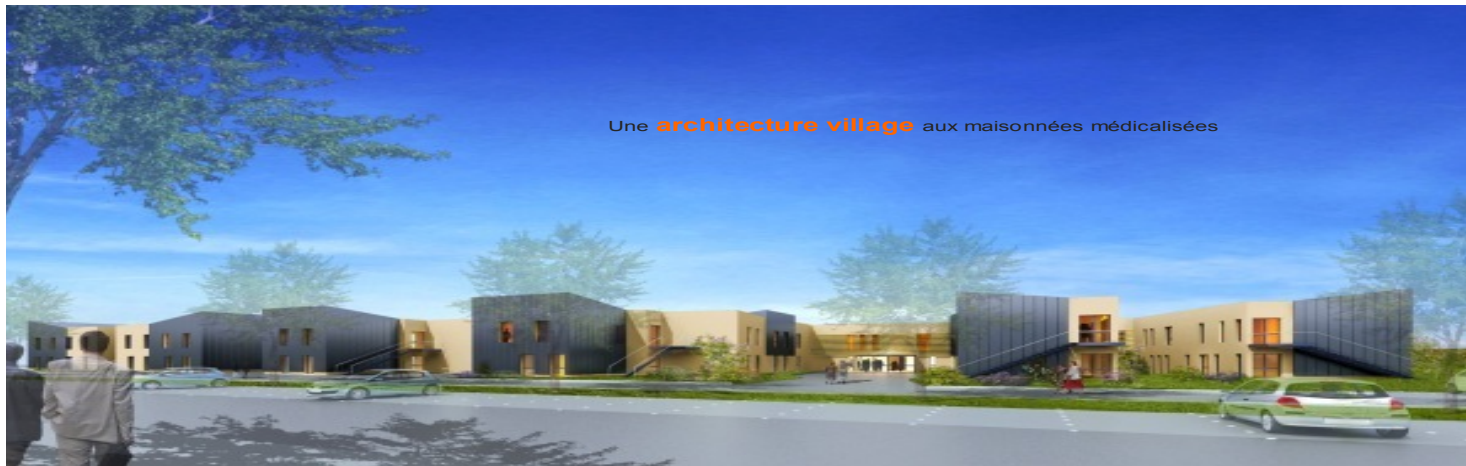
CENTRE D'HÉBERGEMENT ET DE SOINS GÉRIATRIQUES Rochefort-sur-Mer (17)
